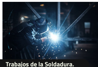
Trabajos de la Soldadura.
