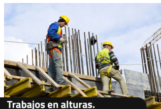
Trabajos en alturas.
