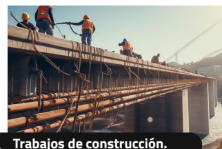
Trabajos de construcción.
