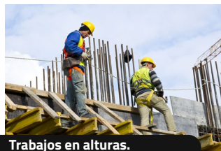
Trabajos en alturas.
