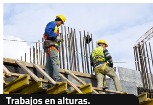
Trabajos en alturas.
