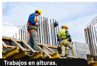
Trabajos en alturas.
