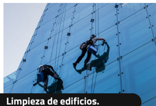
Limpieza de edificios.
