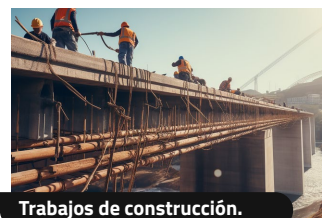
Trabajos de construcción.
