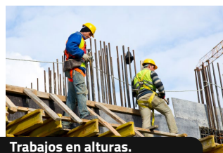
Trabajos en alturas.
