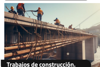
Trabajos de construcción.
