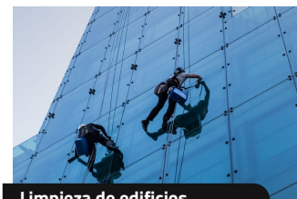
Limpieza de edificios.
