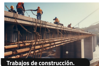
Trabajos de construcción.
