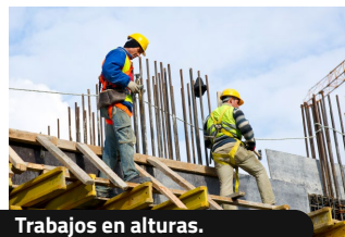
Trabajos en alturas.
