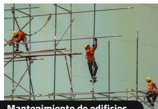
Mantenimiento de edificios.
