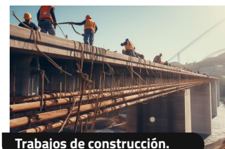
Trabajos de construcción.
