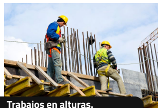
Trabajos en alturas.
