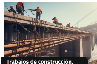
Trabajos de construcción.
