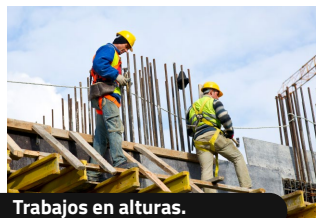
Trabajos en alturas.
