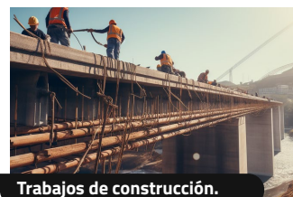
Trabajos de construcción.
