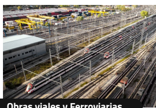
Obras viales y Ferroviarias.
