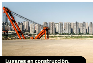
Lugares en construcción.
