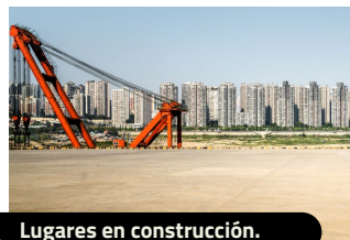
Lugares en construcción.
