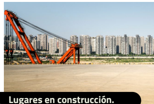
Lugares en construcción.
